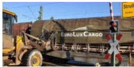
Ein Radlader befördert die verrutschten Stahlplatten wieder zurück auf die Ladefläche Foto: R. Rinklef
